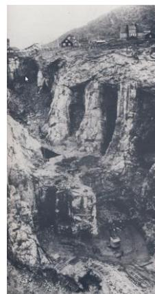
写真4 操業中のイヒドゥート鉱山露天掘
