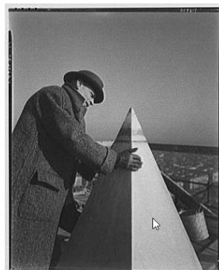
写真8 ワシントン記念塔のアルミニウム・キャップ（1885年）
