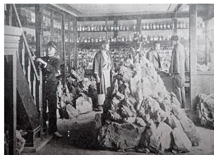
写真 12 金石舎 階下鉱物陳列場
